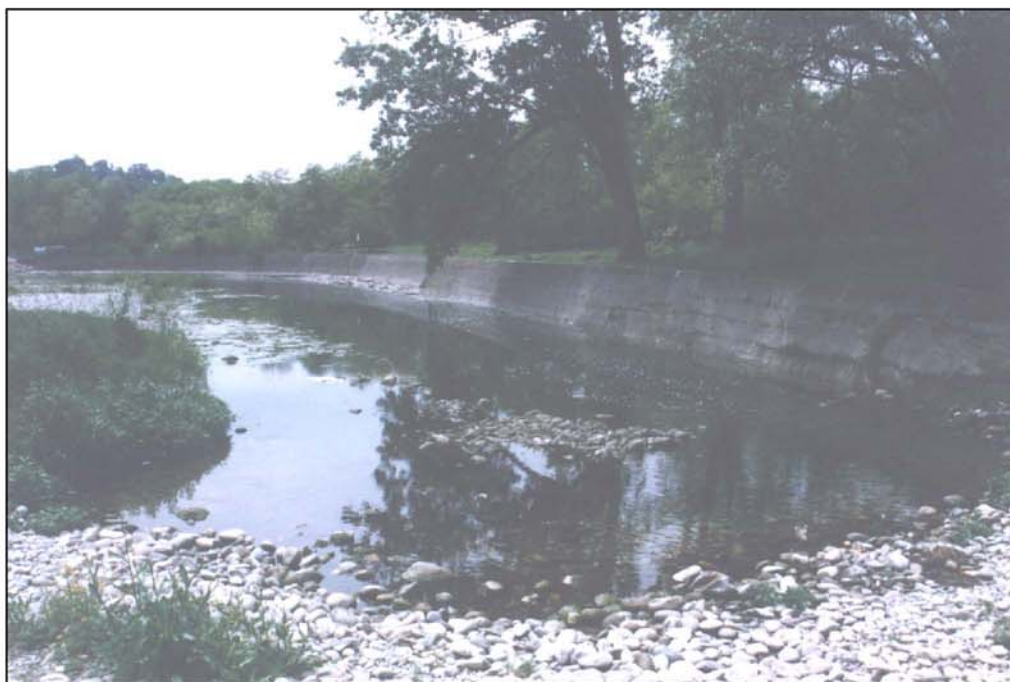
Fotografia 2: Argine artificiale in muratura, presente nella porzione meridionale della penisola di San Gervasio.
