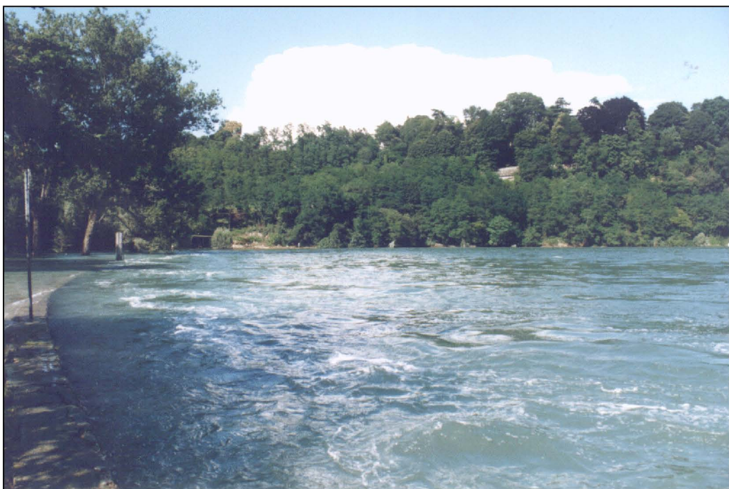
Fotografia 8: Particolare dell'opera di difesa, posta a valle della penisola di San Gervasio e dello sbarramento ENEL, completamente sommersa durante un evento di piena.
