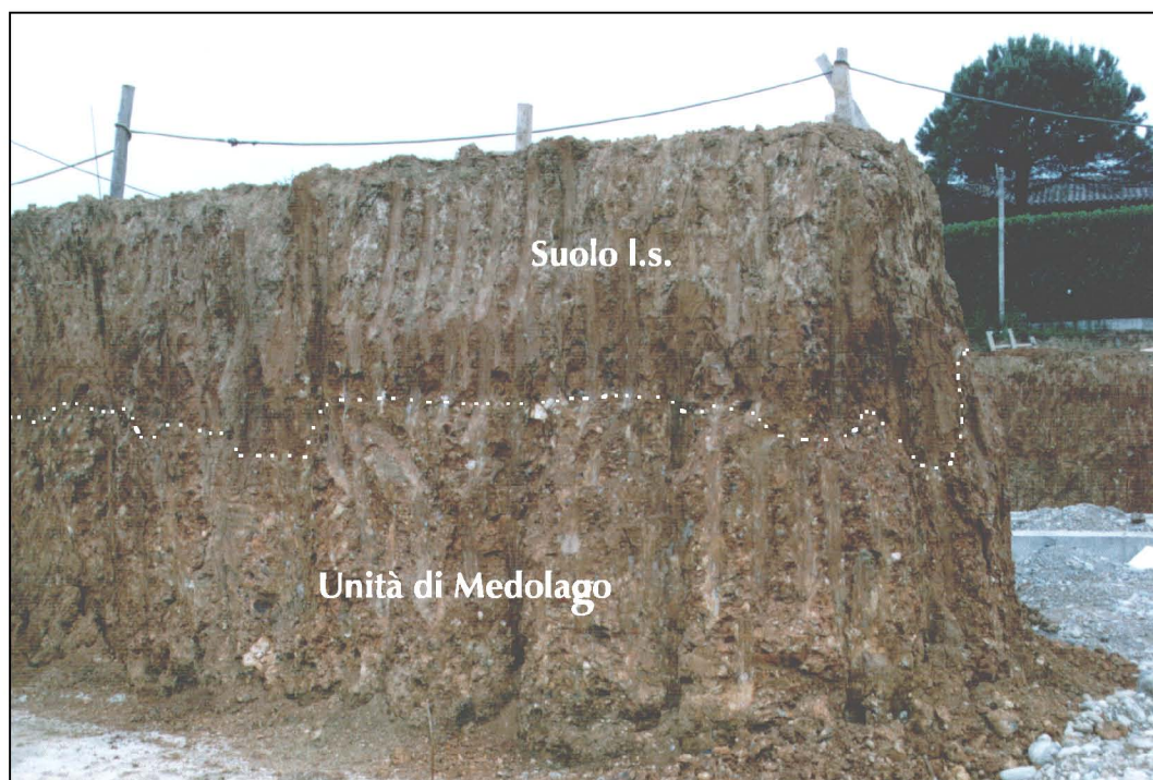
Fotografia 5: Contatto suolo – Unità di Medolago in uno scavo effettuato a nord di via Grignano.
